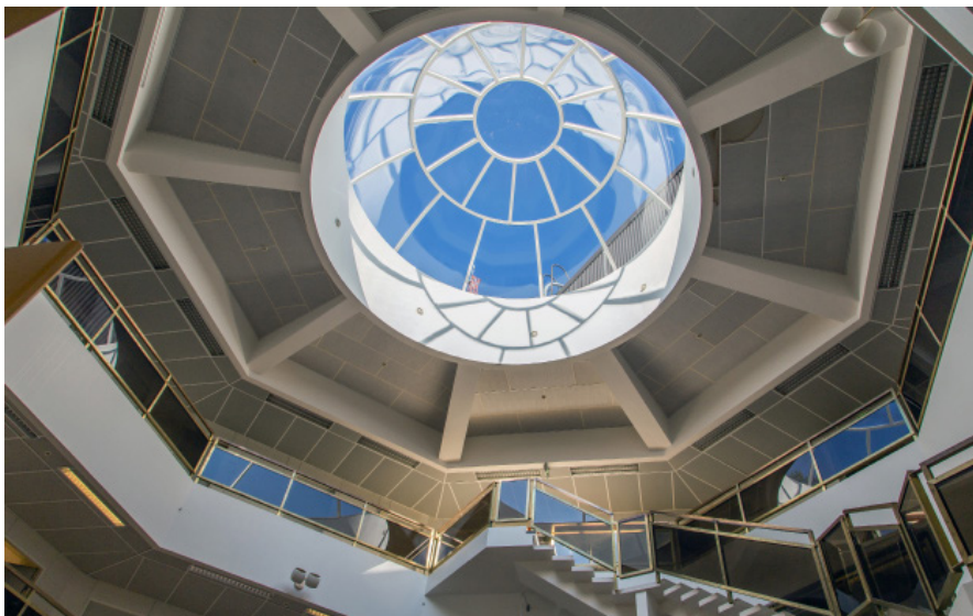
Utbyggd storlek takljuskupol, diameter 6,0 m, Loiste Energis OY, i Kajaani, Finland
