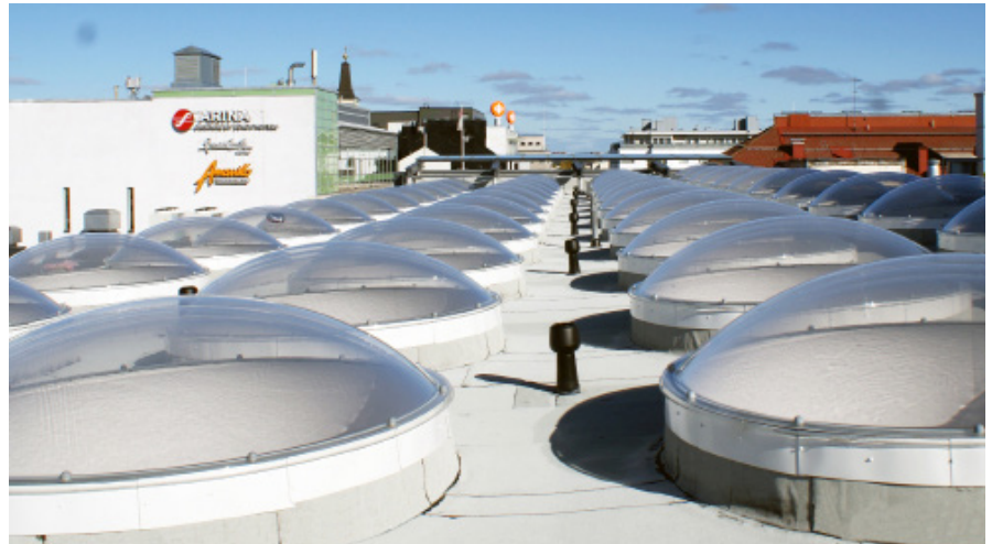
Valkea köpcenter i Oulu, Finland
