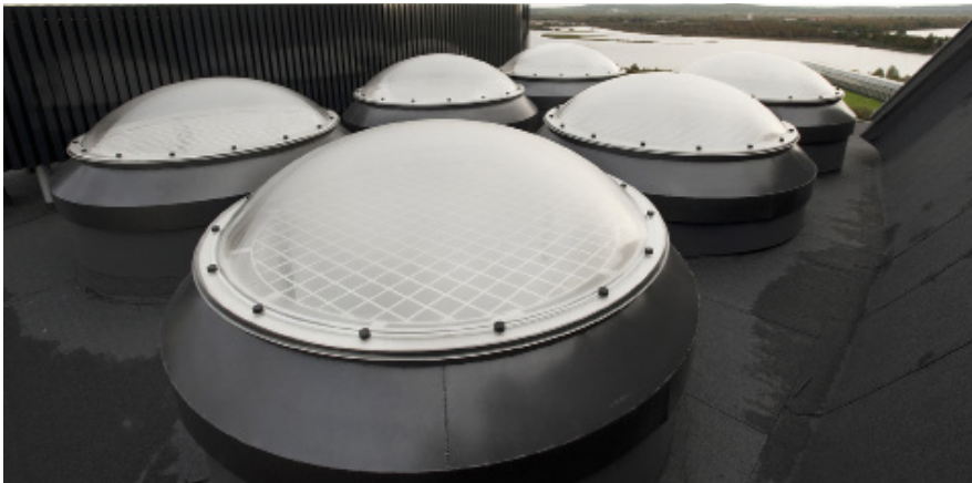
Figur 8 (förråd, enklare byggnader) K1N takljuskupol ERN installationssarg
